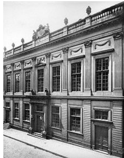
Neue reformierte Kirche am Kornmarkt in Frankfurt erbaut von 1789-1793
